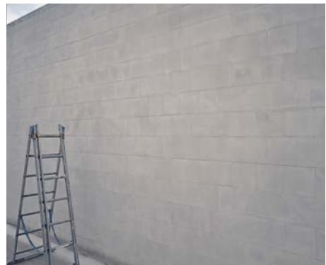
Bild 8 Geschlämmtes KS-Mauerwerk mit KS-Plansteinen
