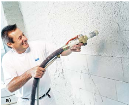
Bild 9 Arbeitsschritte beim Verputzen einer Wand; a) Auftrag des Putzmörtels; b) Glätten der Putzoberfläche
