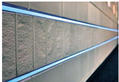
Bild 4 Innensichtmauerwerk aus KS-Fasensteinen kombiniert mit LED-Technik
