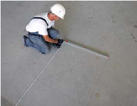
Bild 5 Festlegen der Abstellfläche von Stein stapeln und Mörtelkübeln am Verarbeitungsort
