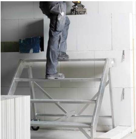
Bild 12 Der Einsatz von fahrbaren Maurertreppen erleichtert das Verarbeiten.
