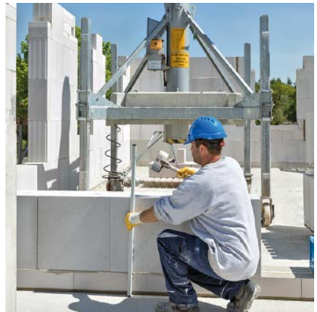
Bild 13 Eine gute Baustellenorganisation ermöglicht durchgängiges Arbeiten.
