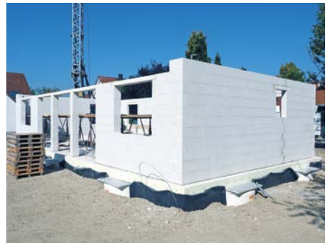
Bild 8 Eine aufgeräumte Baustelle ist die beste Werbung.
