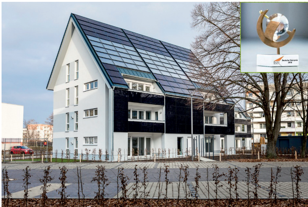
➤ Abb. 5: Zwei fertiggestellte energieautarke Mehrfamilienhäuser in Cottbus. Quelle HELMA. Dieses Projekt wurde mit dem Deutschen Solarpreis 2018 geehrt. Quelle: Eurosolar
