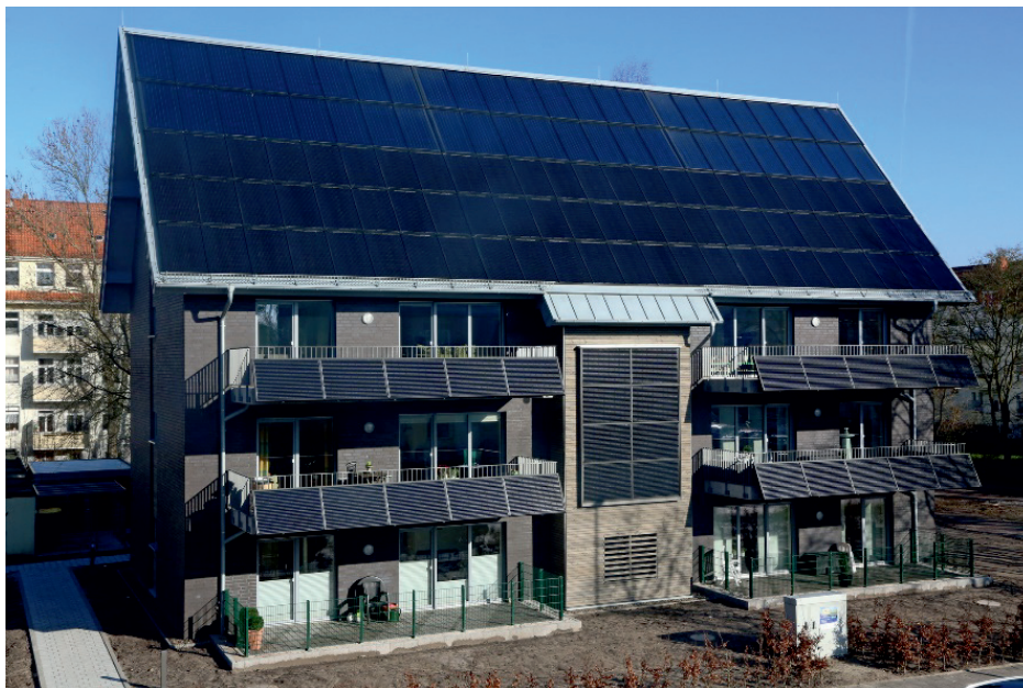
➤ Abb. 7: Miete mit Energieflat: Ein vermietetes energieautarkes Mehrfamilienhaus mit je 6 Wohneinheiten in Wilhelmshaven, Fertigstellung 2018. Solartechnik auf dem Dach und an den Balkonen mit Energiespeicher erreichen etwa 70 Prozent solare Deckung des Strom- und Wärmebedarfs. Der Vermieter bietet dem Mieter für 10 Jahre eine Pauschalmiete an, in der Wohnen, Wärme, Strom und E-Mobilität als Flatrate bereits enthalten ist.
