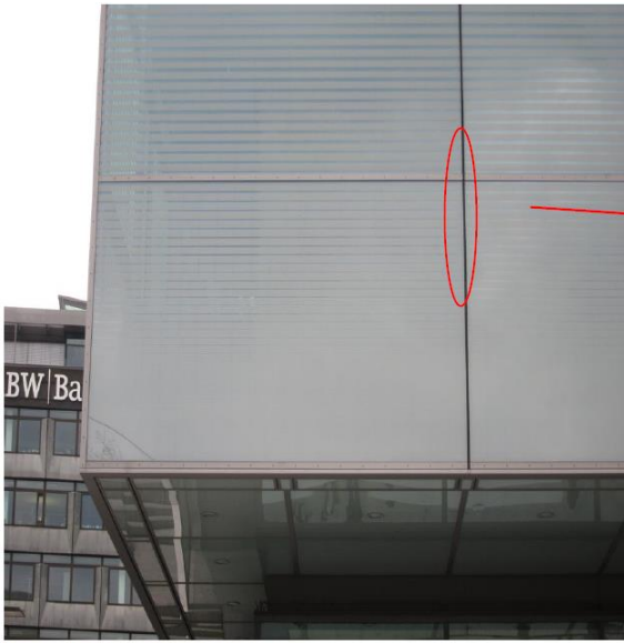
Ansicht der Ecksituation
