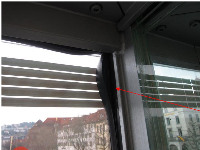
Detailansicht Fassaden- ecke von der Raumseite gesehen
