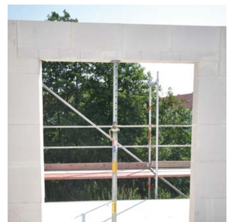
Überdeckung einer Türöffnung mit einem KS-Flachsturz und Übermauerung aus Passtückeln
