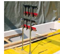
...an den Heizkreisverteiler
