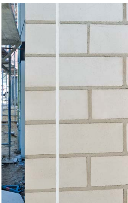
Dehnungsfuge in der unverputzten Vormauerschale an der Gebäudeecke
