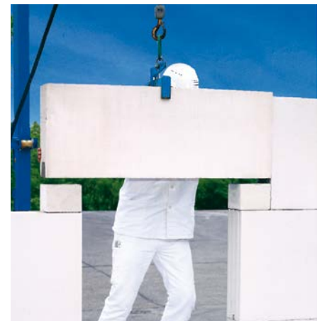
Versetzen eines KS-FTS-Fertigteilsturzes. Allgemeine bauaufsichtliche Zulassung Z-17.1-621
