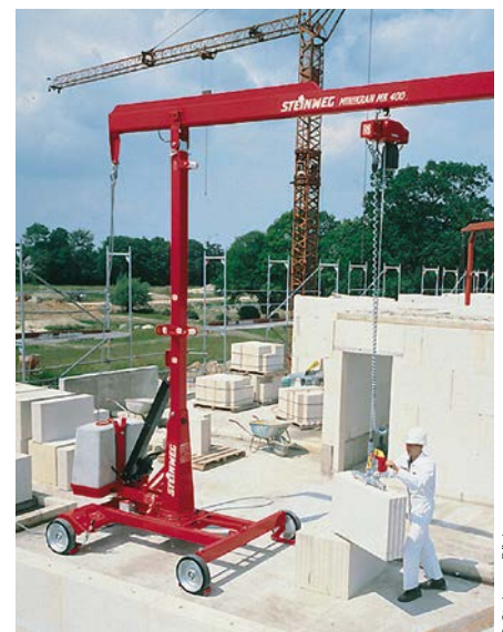
Arbeiten mit dem Versetzgerät
