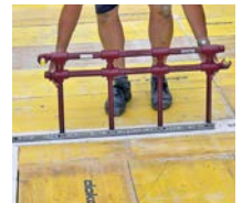
Einfädeln des Temperierungsmoduls
